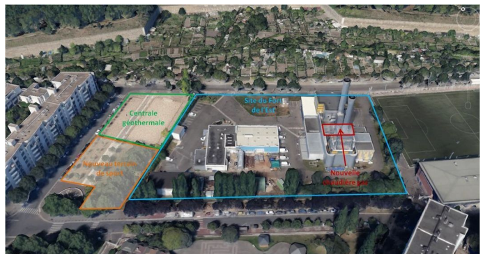
Figure 3: Vue aérienne du site actuel - Étude d'impact p. 82.
